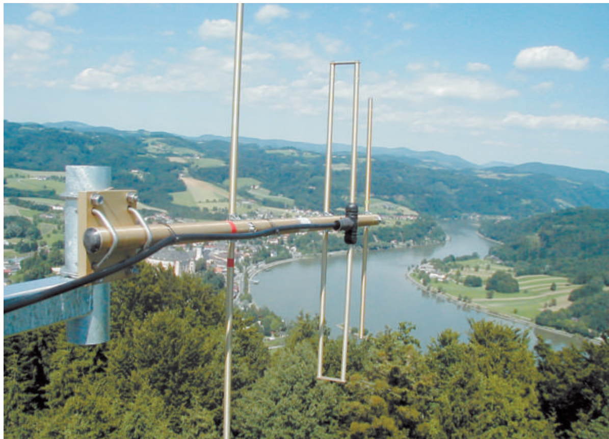
Richtantenne in Grain: Ab 2007 müssen alle Schiffe, die die österreichische Donau befahren wollen, ihre Identifikationsnummer durchfunken. Die Infrastruktur an Land steht schon jetzt. Foto: Via Donau
