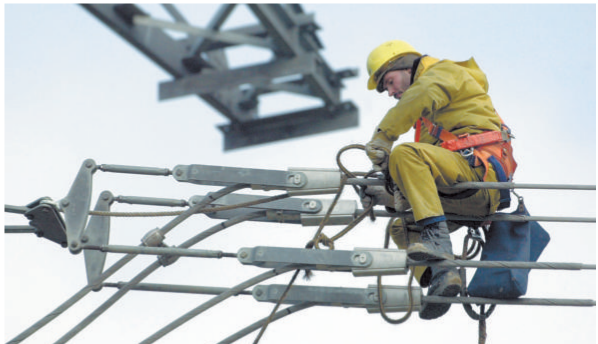
Nach dem Kurzschluss der großen österreichischen Stromlösung Ösl sucht Österreichs E-Wirtschaft fieberhaft nach Möglichkeiten, die Drähte in der Branche neu zusammenzuspannen. Foto: dpa/Roessler
