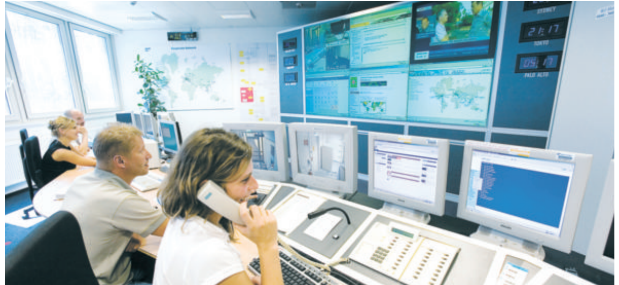
Serviceorientierte Architektur bringt Klarheit in komplexe IT-Systeme. Im Bild: die SAP Hosting Data Center Control Station. Foto: SAP Österreich
