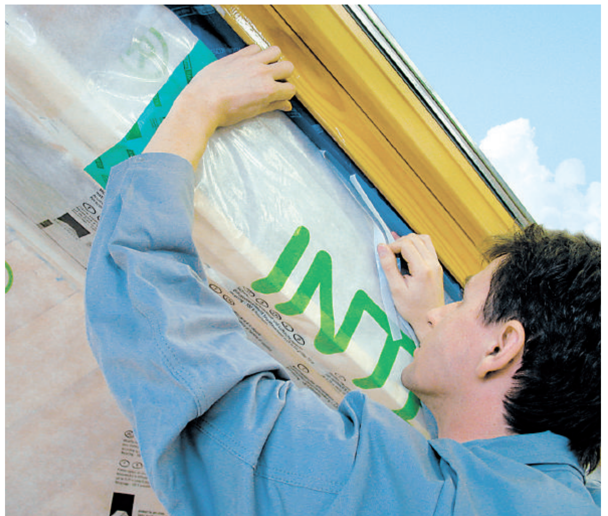
Innovativer Holzbau in Kombination mit der Verwendung bester Baustoffe schafft die Voraussetzungen für behagliches Wohnen und lange währende Zufriedenheit. Foto: Harrer
