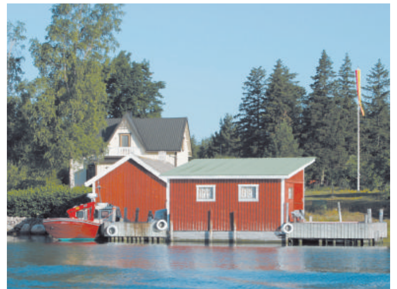
Unaufgeregt wird im hohen Norden seit über 20 Jahren an der Gesamtschule festgehalten – mit viel (Pisa-) Erfolg. Foto: Photos.com
