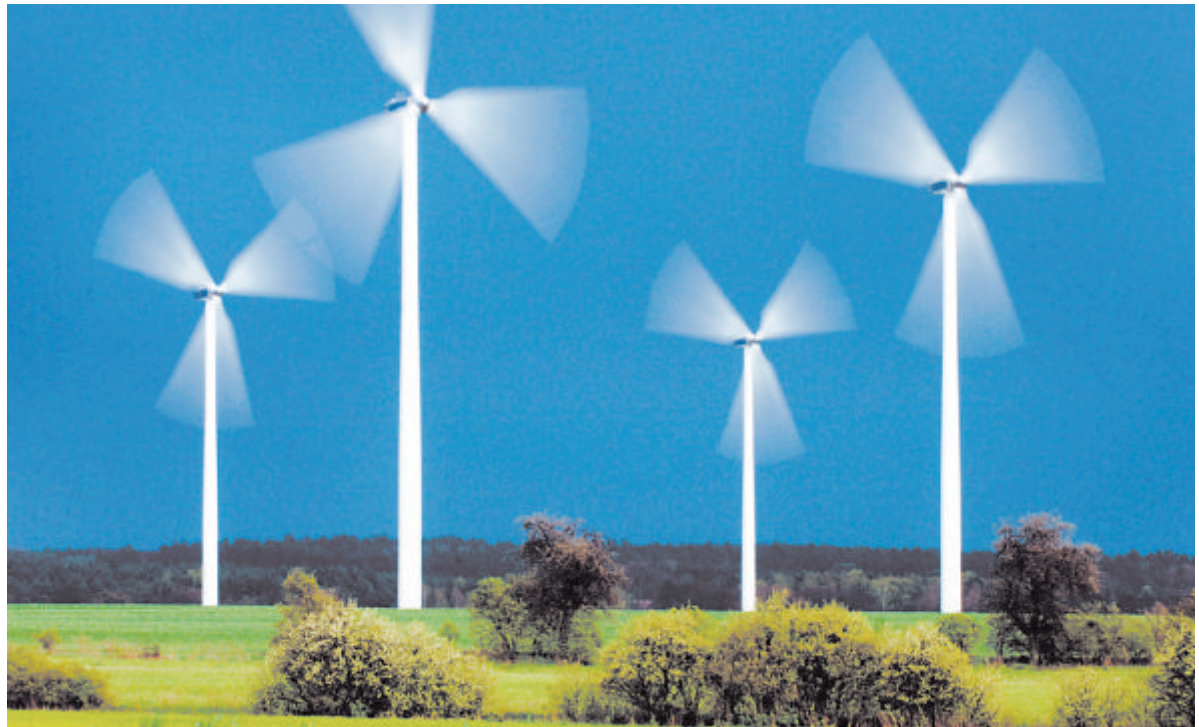
Der Ausbau der Windenergie stagniert in Österreich. Schuld daran ist das Ökostromgesetz. Die IG Windkraft fordert eine Novellierung der Novelle. Foto: dpa/Pleul
