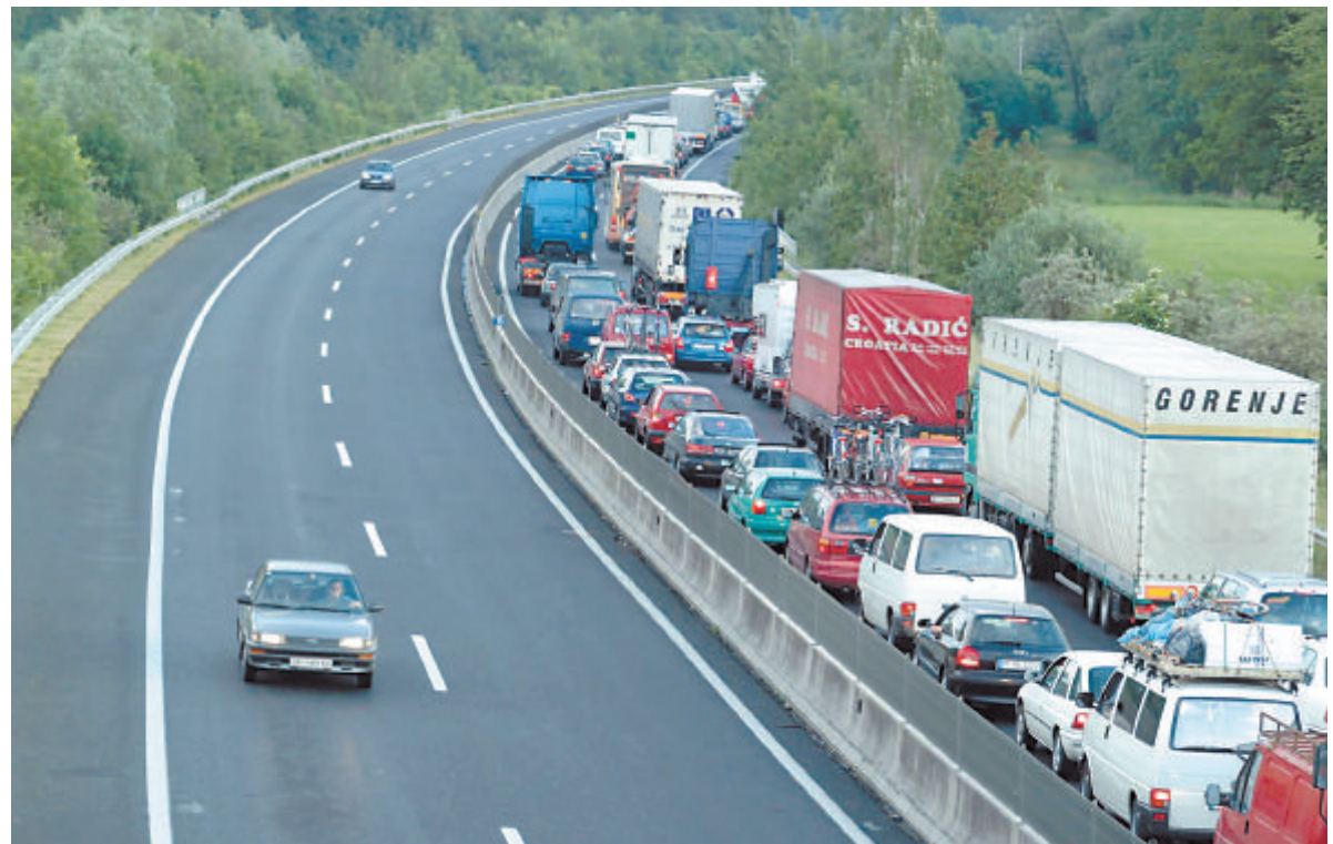
Die Umweltbelastung soll mit alternativen Antrieben radikal vermindert werden. Technisch ist vieles schon machbar. Vieles ist nicht gewollt. Und die Rahmenbedingungen fehlen. Foto: Bilderbox.com
