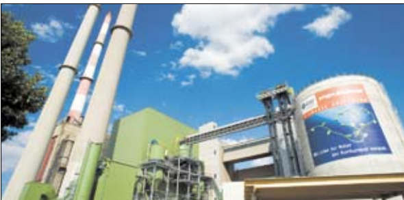
Foto: Wien Energie
